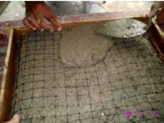
Imagen 1. Panel de mortero armado con mallas de plástico
